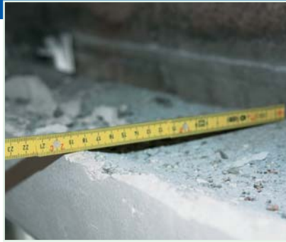
2 Aufmaß des Kasteninnenraumes, Länge und Dämmstärke der Dämmplatten festlegen.
