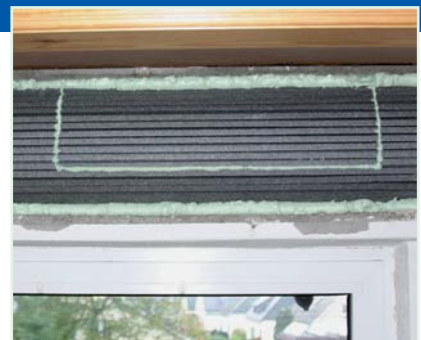
12 Zu Revisionszwecken: Dämmung links + rechts sowie unten einschneiden und Dämmung aufklappen. Nach Revision, Schnitte wieder verkleben und abdichten!
