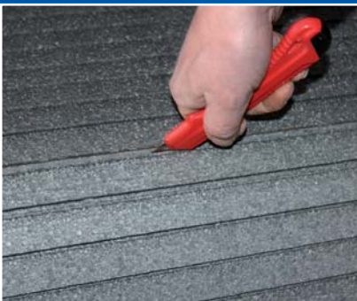
4 Platte einfach mit Cutter-Messer auf Maß schneiden.
