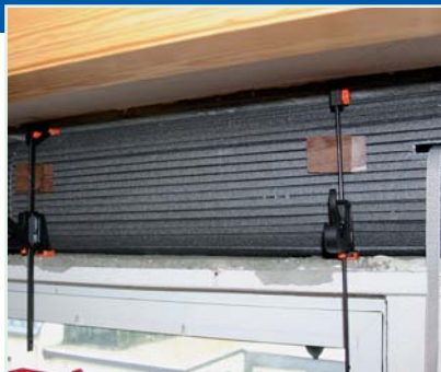
8 Dämmung fixieren! (Spreize oder Dachlatte verwendbar)
