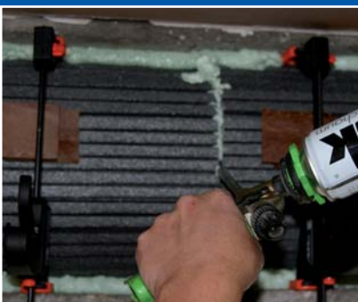
10 Dämmplatten in allen Stoßbereichen sowie zum Mauerwerk mittels Montageschaum fixieren und abdichten.
