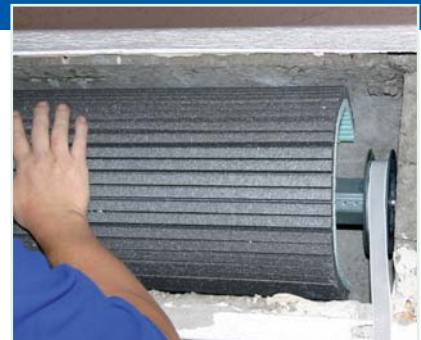
6 Dämmplatte einsetzen. Die Dämmung benötigt am Sturz und oberhalb des Blendrahmens einen Anschlag. (z.B. Winkel setzen)
