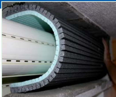
5 Plattenlänge und Rollraum prüfen. Nach Möglichkeit Seitenteildämmung einbauen.
