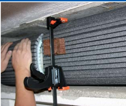
7 Zwischenstücke ausmessen und einsetzen.
