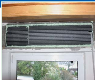
11 Thermo-Flex ist fertig montiert.
