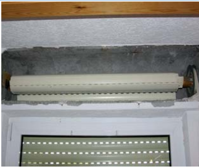
1 Ansicht zu Beginn der Sanierung.
